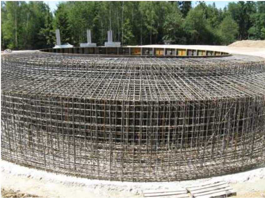
Eisenarmierung im Fundament
