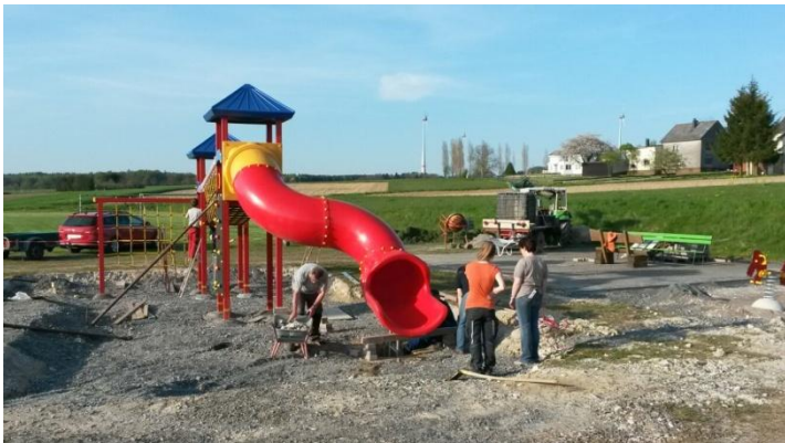
In der Bauphase
